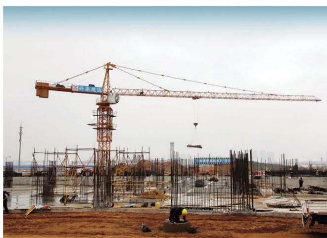
2月28日,在我市首个复工项目鄂尔多斯蒙古族学校项目建筑工地,头戴安全帽的工人们在钢筋笼上一字排开,用点焊将连接处逐个加固。远处,一座座重型机械在作业平台上上下下运转,勾画出一幅热火朝天的复工建设图景。
