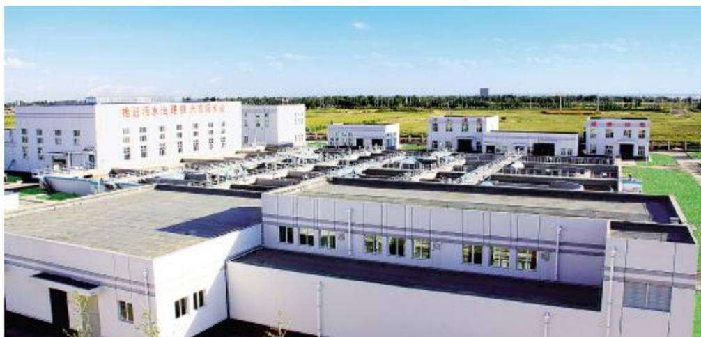
了膜生物反应器污水资源化技术，这也是膜生物反应器污水资源化技术项目首次入驻内蒙古地区。先进的膜技术在化学需氧量和氨氮指标控制上较传统工艺有明显的优势，在传统一级A标准的基础上可继续减排百分之五十以上，是现代化新型污水处理厂技术指标的可靠保证。
